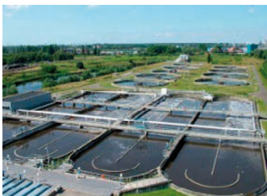
Уламжлалт идэвхт лагийн аэробик цэвэрлэгээ (сүвгийн төрөл)
