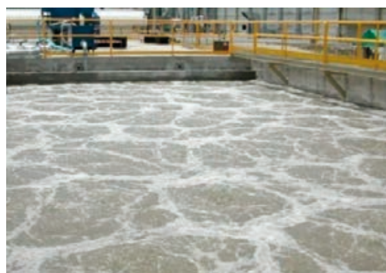
Уламжлалт идэвхт лагийн аэробик цэвэрлэгээ
